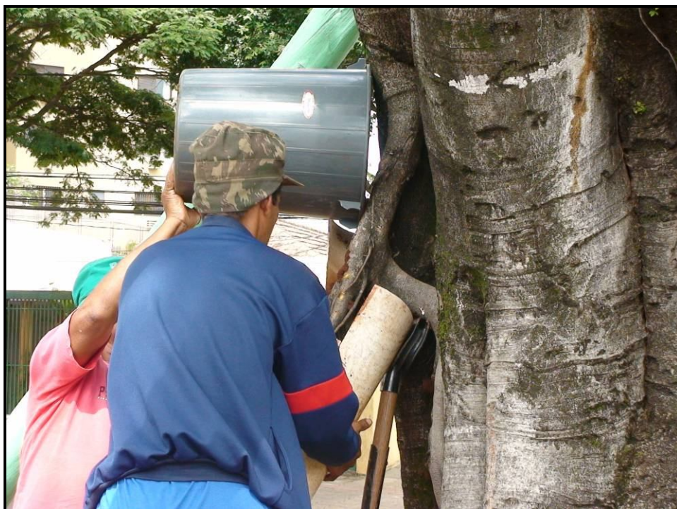
FOTO 29 – Vista preenchimento solo dos tubos de indução raízes;
