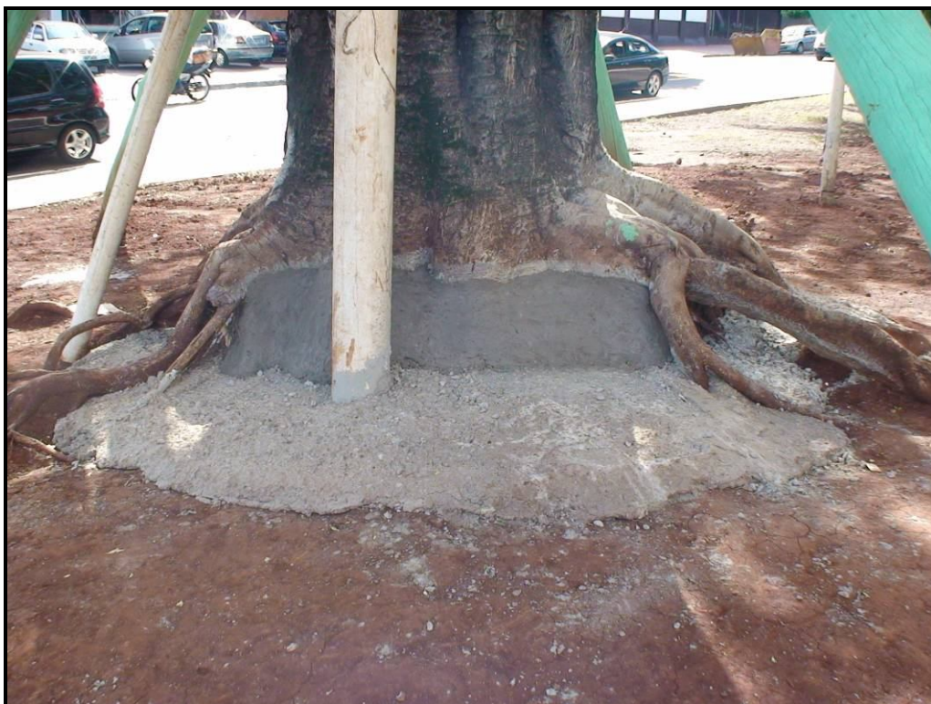
FOTO 40 – Fase final dos trabalhos vista 3 da Base do Tronco reconstituído;
