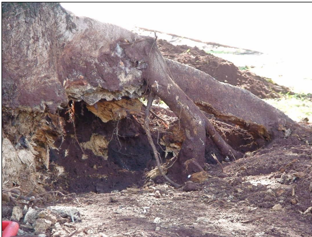
FOTO 07 – Ao aprofundarmos a escavação notamos então o comprometimento desta planta em seu sistema radicular e base tronco;
