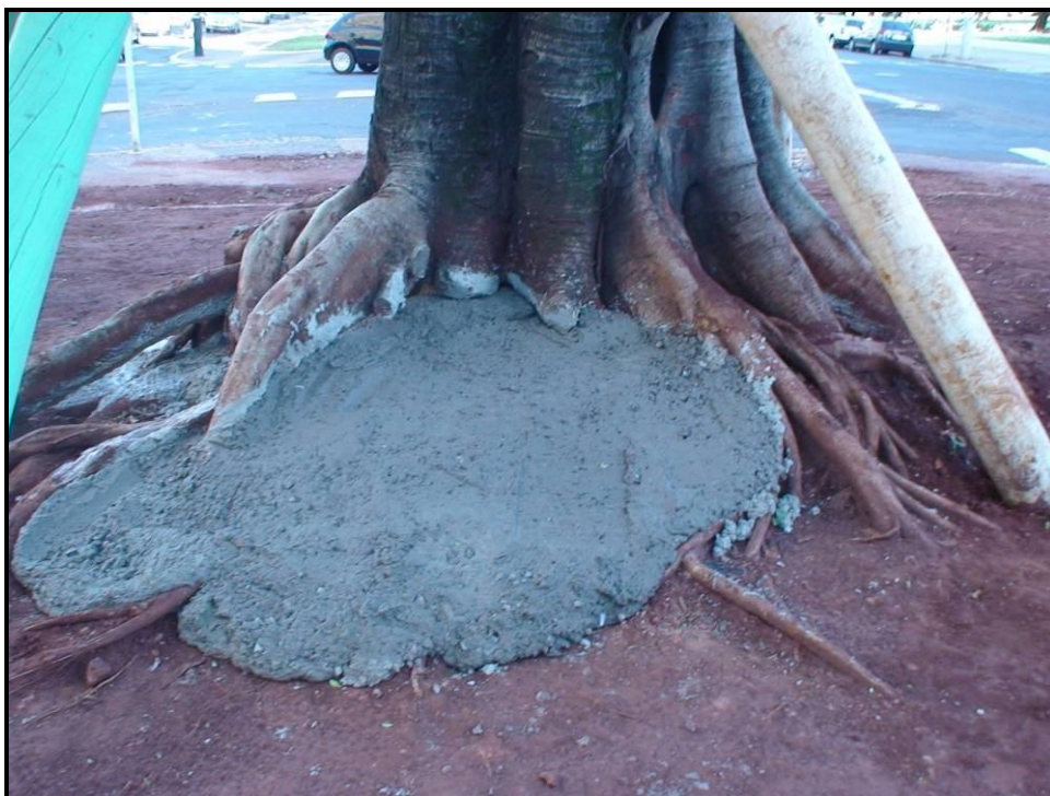
FOTO 32 – Colocação de argamassa para preenchimento das partes necrosadas material inerte primeira fase;
