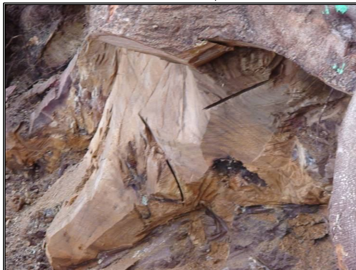
FOTO 16 – Imagem após o processo de limpeza de áreas afetadas;
