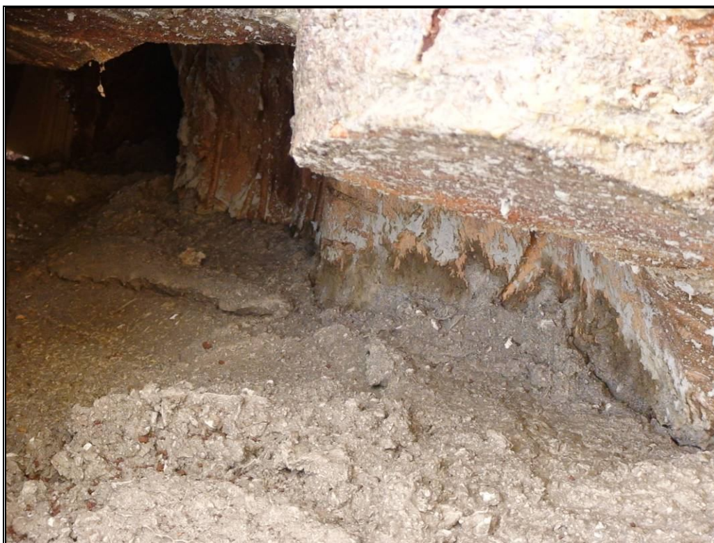
FOTO 33 – Período de cura da primeira fase de aplicação de argamassa;
