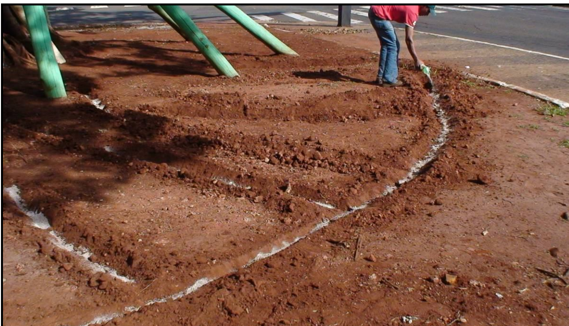
FOTO 42 – Fase final dos trabalhos preparação do terreno para incorporação de fertilizantes;
