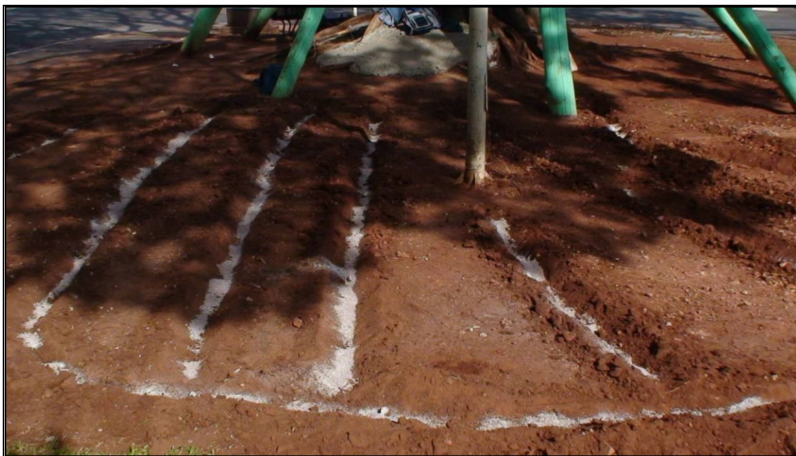
FOTO 44 – Fase final dos trabalhos preparação do terreno para incorporação de fertilizantes;
