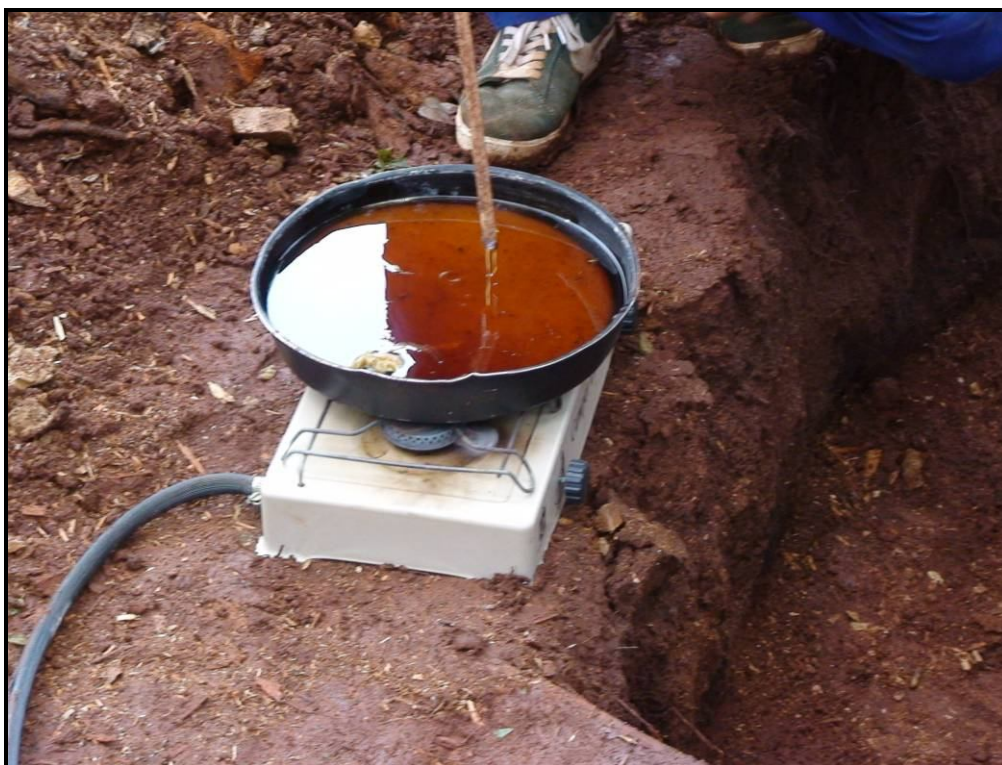
FOTO 21 – Preparação da calda “Mastique”;
