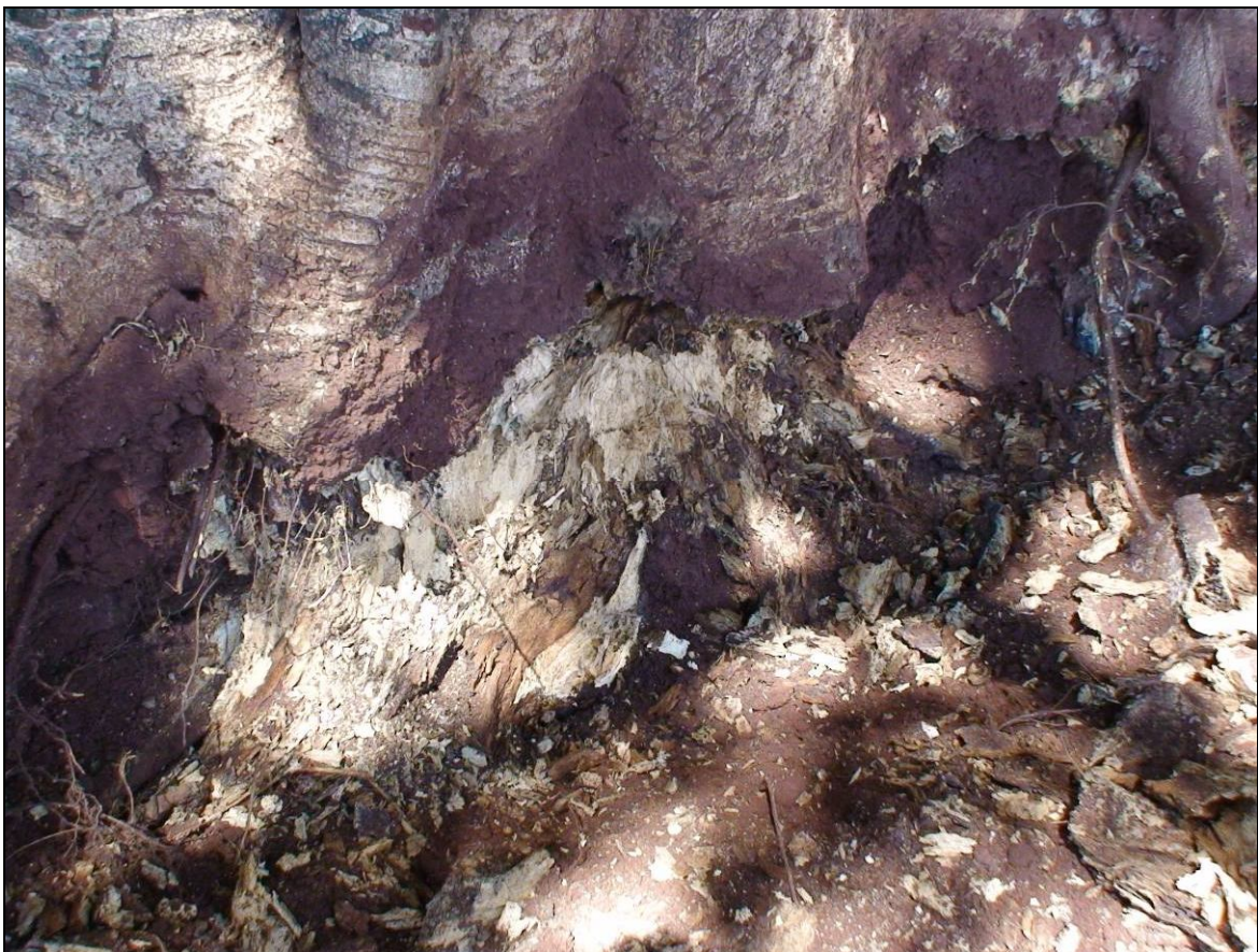
FOTO 06 – Ao aprofundarmos a escavação notamos então o comprometimento desta planta em seu sistema radicular e base tronco;
