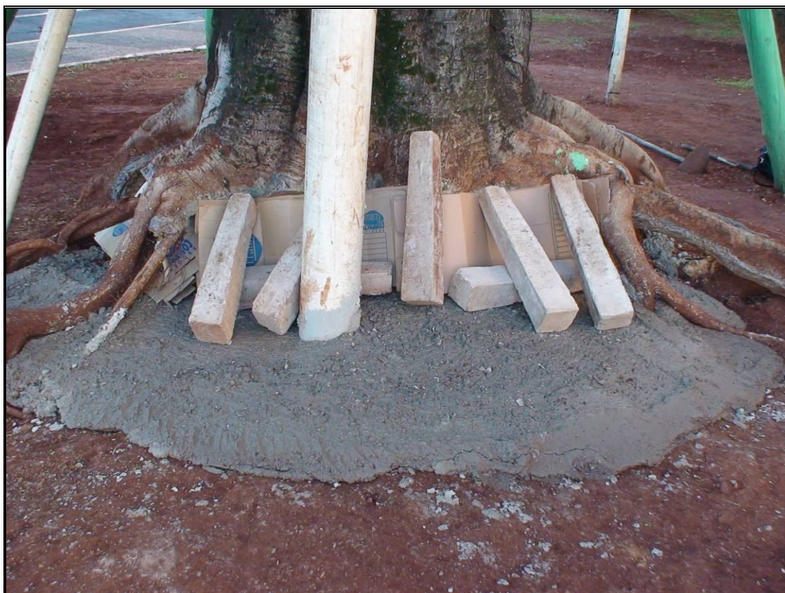
FOTO 35 – Preparação para recebimento argamassa segunda fase reconstituição base tronco;
