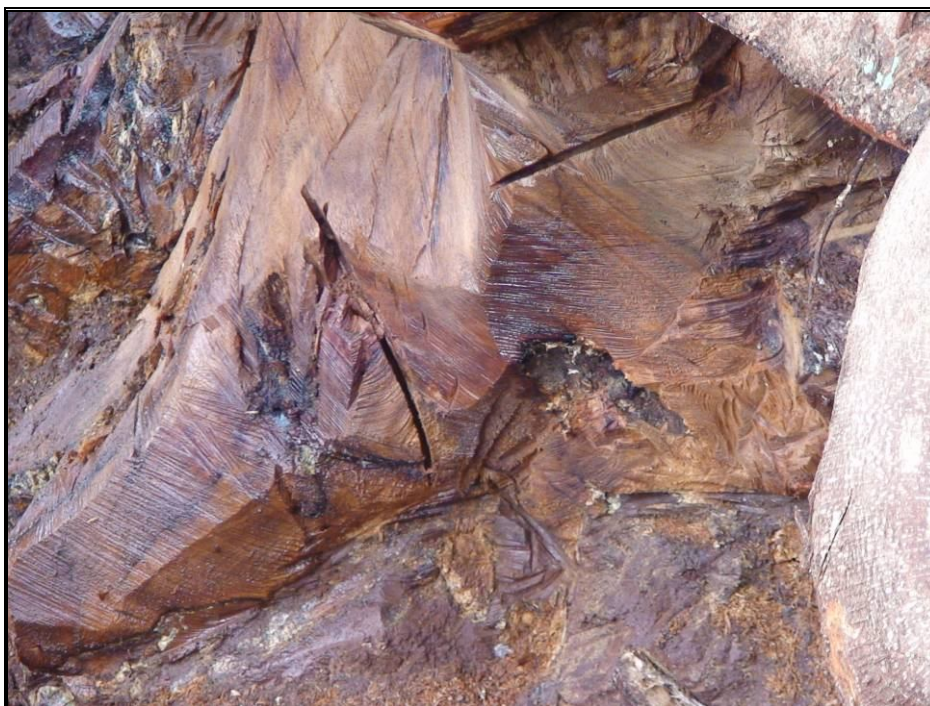
FOTO 20 – Imagem após tratamento com a calda bordaleza a base de Sulfato de Cobre;
