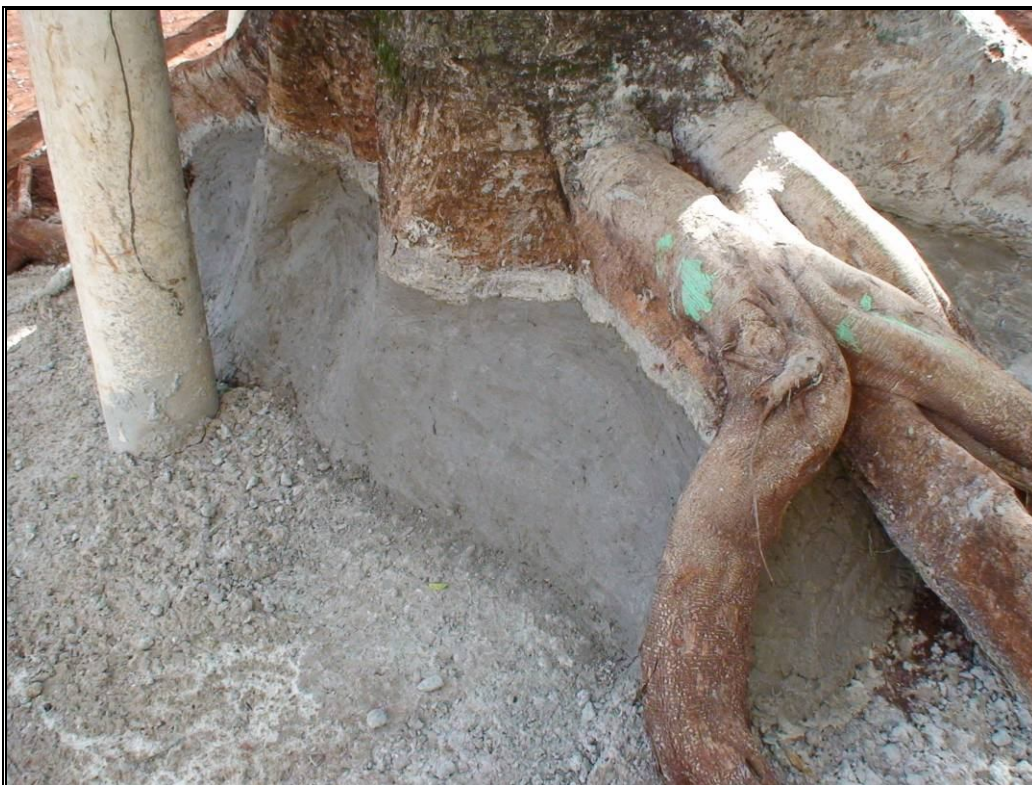
FOTO 39 – Fase final dos trabalhos vista 2 da Base do Tronco reconstituído;
