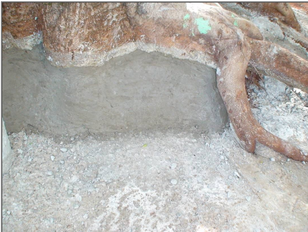
FOTO 38 – Fase final dos trabalhos vista 1 da Base do Tronco reconstituído;
