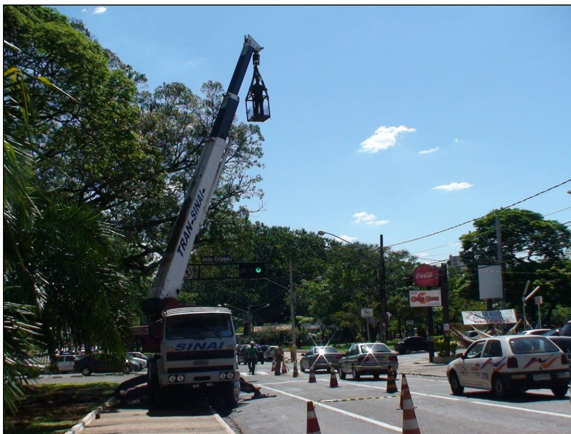
FOTO 09 – Vista caminhão muck utilizado para poda;
