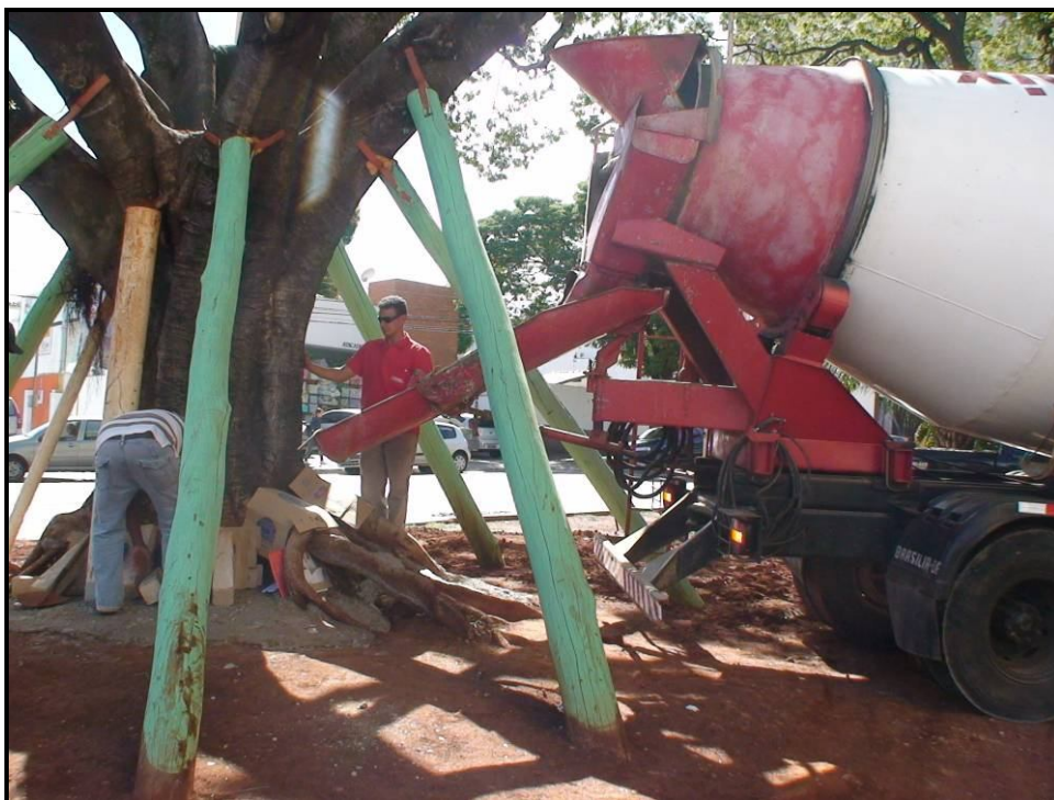
FOTO 31 – Vista preparação colocação de concreto usinado e ecológico;
