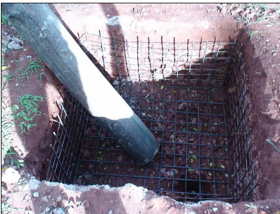
FOTO 13 – Vista preparação para ancoragem;
