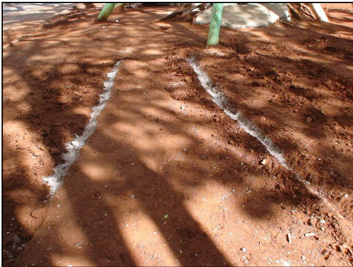
FOTO 43 – Fase final dos trabalhos preparação do terreno para incorporação de fertilizantes;
