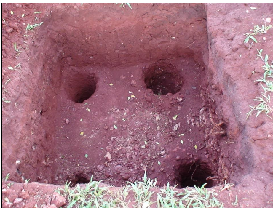
FOTO 12 – Vista preparação para ancoragem;
